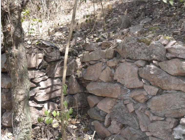
Imagen 2: parte del muro elevado con pirca seca
