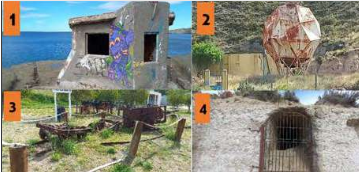
Imagen 1: Mareógrafo de Puerto Pirámides: estación de medida de las mareas, inaugurado en 1945. Actualmente se encuentra en desuso y su construcción en permanente deterioro. Imagen 2: Tanque de Agua. Se instaló en la década de los 70 para usarlo como depósito municipal, pero por una falla de arquitectura nunca pudo inaugurarse. Imagen 3: Restos de Tren Salinero asociado a la industria de las Salinas. El mismo dio origen al nacimiento de Puerto Pirámides como localidad, el 14 de julio de 1900. Se encuentra en la Plaza San Martín de la localidad de Puerto Pirámides. Imagen 4: Cueva usada como depósito de exportaciones de sal, aceite de lobos marinos y lanas de la industria ovejera. Asociada al tren salinero, su uso data de las primeras décadas del 1900. Fotografías de la autora.
